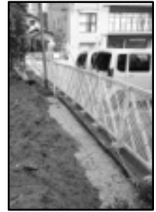
【→教会敷地南側の塀の工事→】
